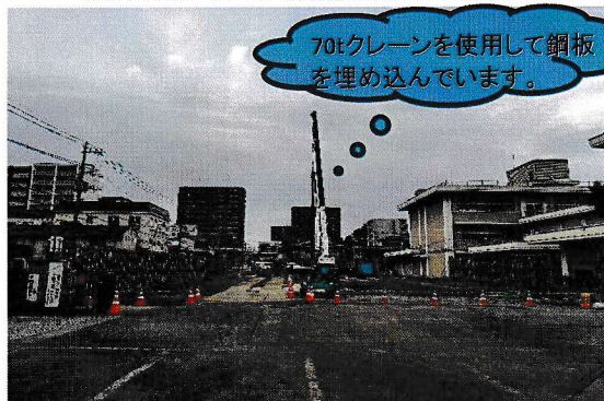
山留工事は年内で 終了予定です。
